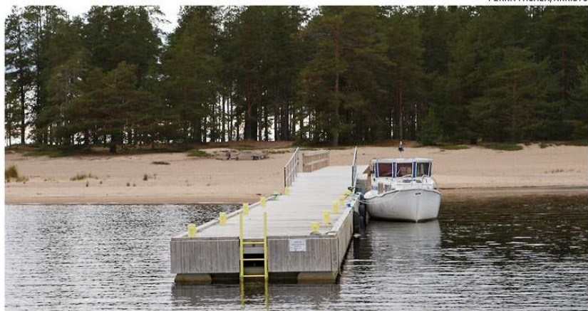
Katera Steelin työtä on muun muassa Ärjän laitur.
